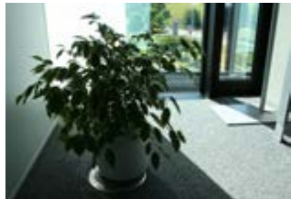
Abb. 2: Zugestellter Luftauslass.
