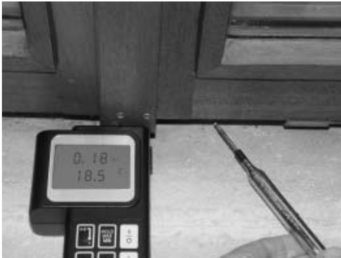
Abb.24: Messung an einer Fensterfuge
